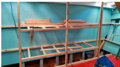
Primeros listones para la estructura de las literas y forro pintado en el color original
