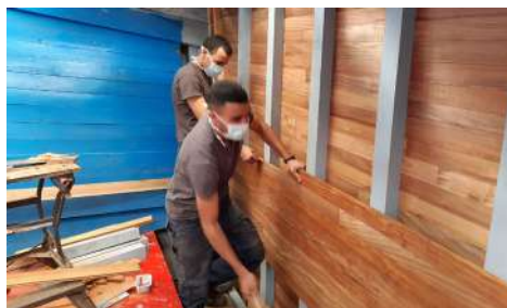
Forrando el interior del mamparo de la nevera
