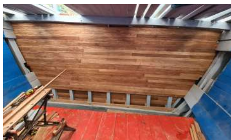
Forro interior terminado
