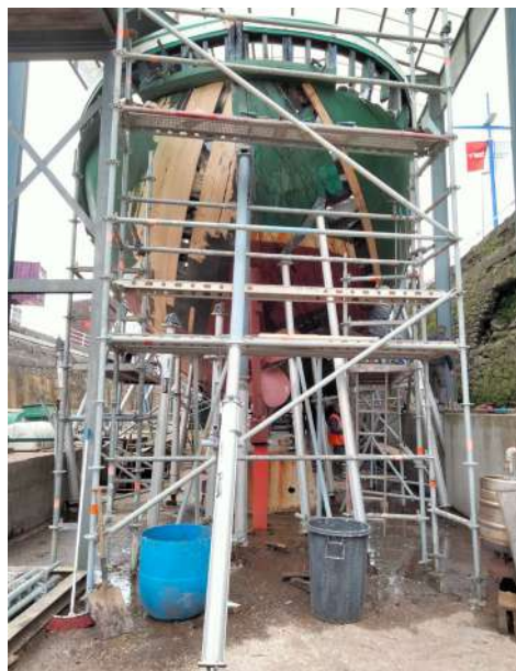
Eliminados los soportes
