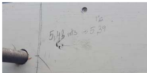
Anotaciones con la distancia antes de aproximar las bandas y seguido la distancia obtenida el primer día
