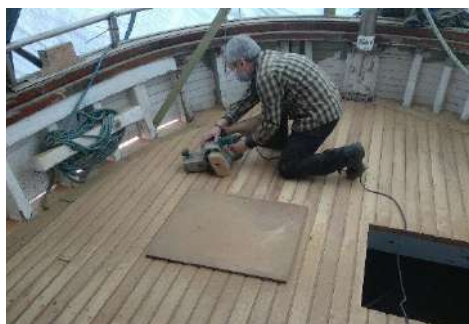
Lijado de la cubierta
