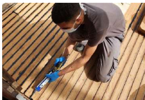
Sellado y lijado de las juntas de cubierta con Sikaflex 290 Dc Pro
