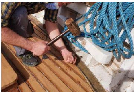
Calafateado con algodón de la junta entre la tapa de trancañil y la cubierta
