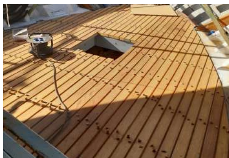
Zona de proa de la cubierta a falta de calafatear. Fue necesario retirar el embono antiguo para rehacer la cubierta en la roda
