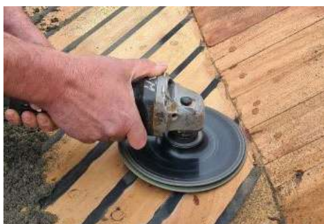
Sellado y lijado de las juntas de cubierta con Sikaflex 290 Dc Pro
